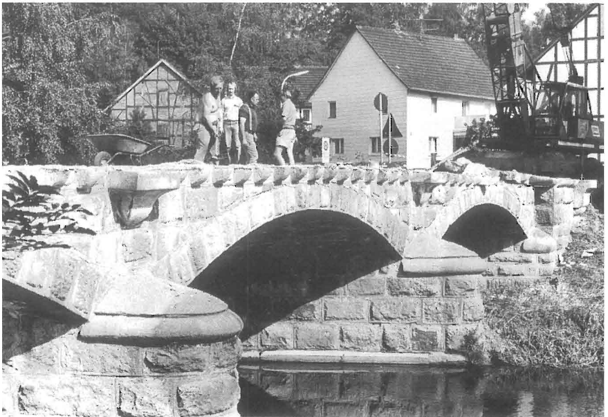
Die Emsbrücke wird renoviert, die Charakteristik bleibt erhalten
